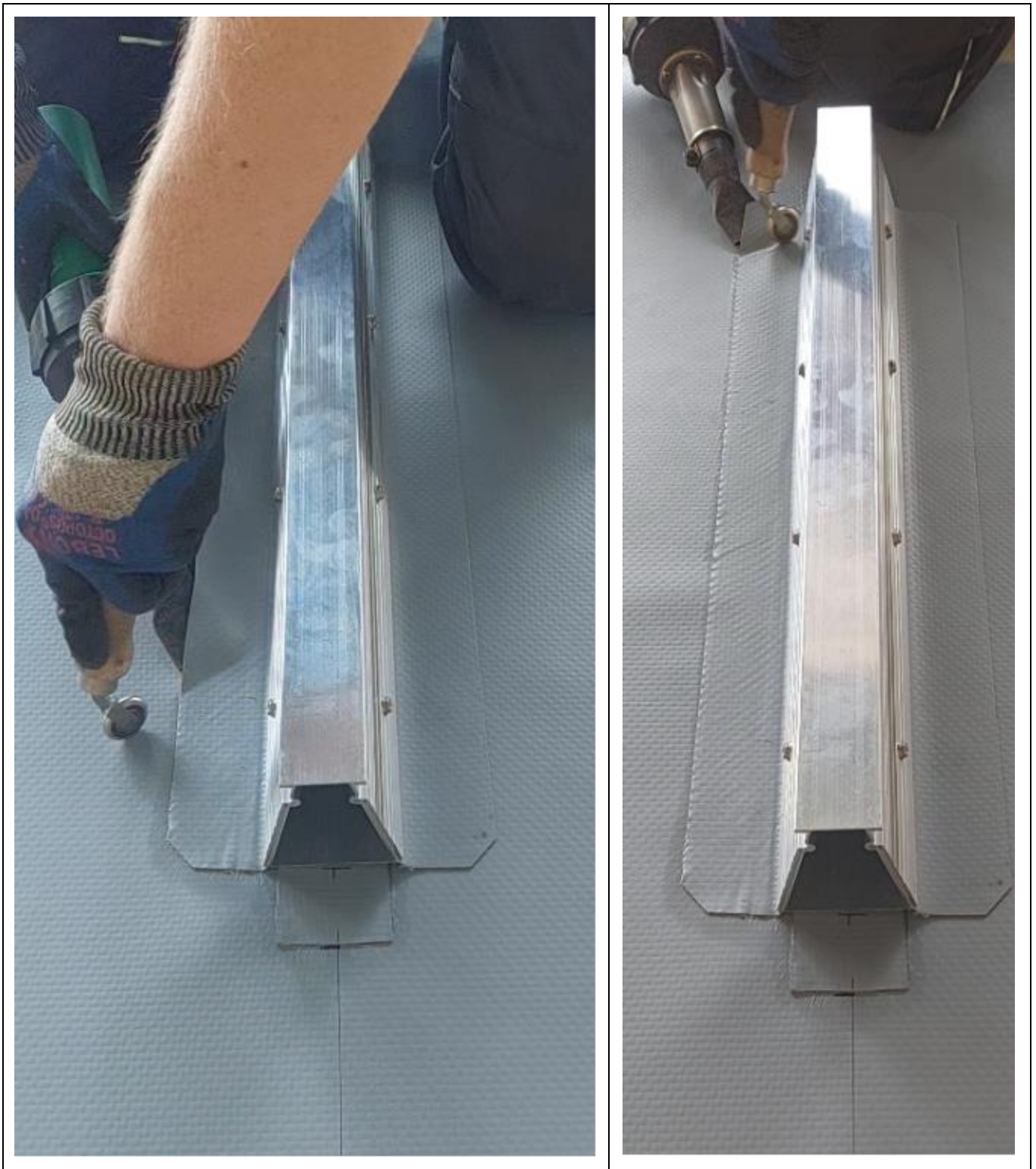
Figure 31 - Soudage sur toute la largeur de la bande de maintien d'un ensemble « Rail »
