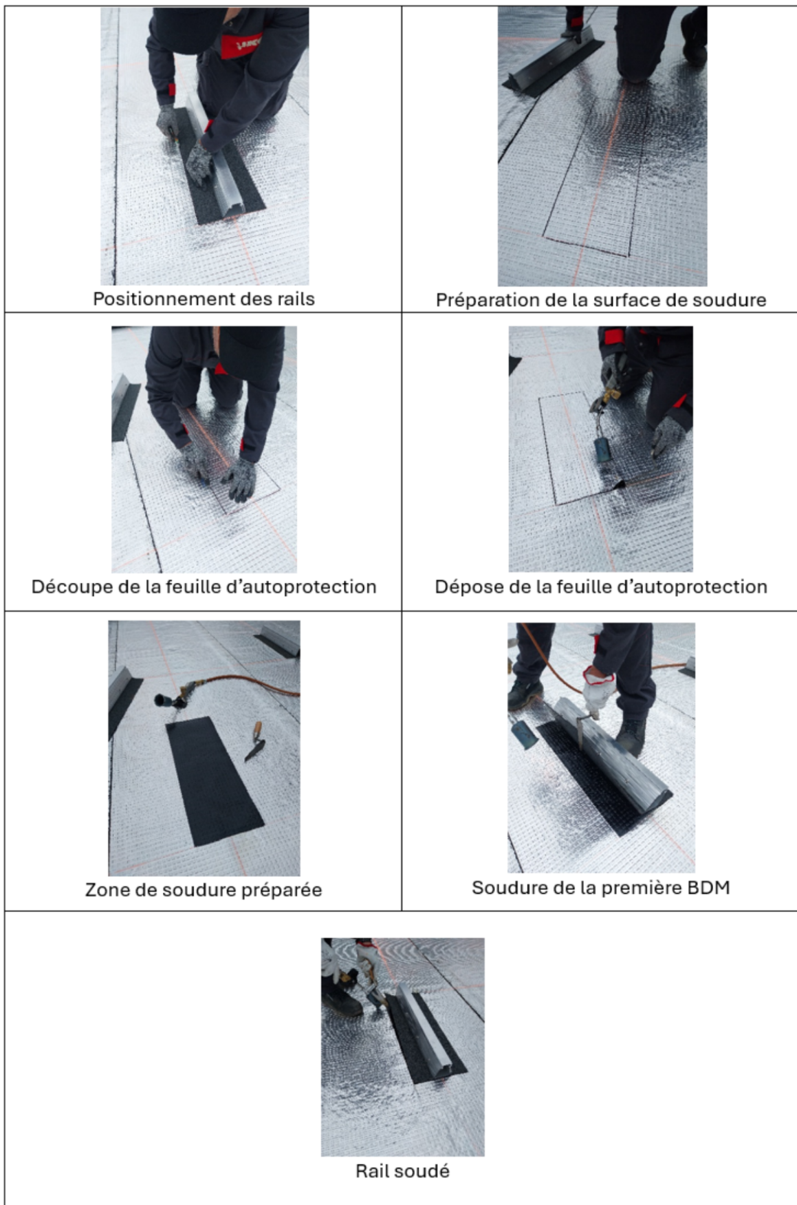
Figure 31 - Soudure d'un rail avec seconde couche IKO DUO SOLAR ALU/F (aluminium)
