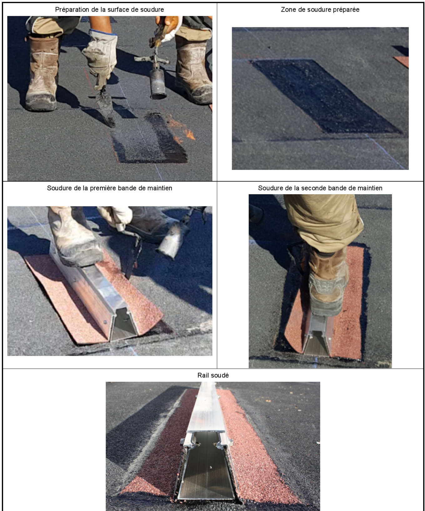
Figure 30 - Soudure d'un rail avec seconde couche IKO DUO ACIER 3000 FEU L4 AR/F (ardoisée)
