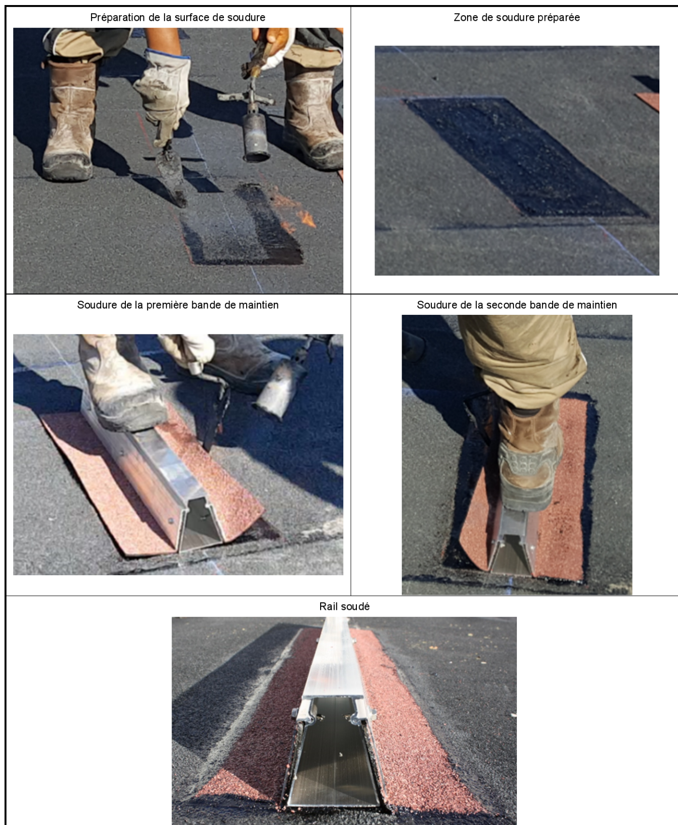
Figure 28 - Soudure d'un rail avec seconde couche ardoisée
