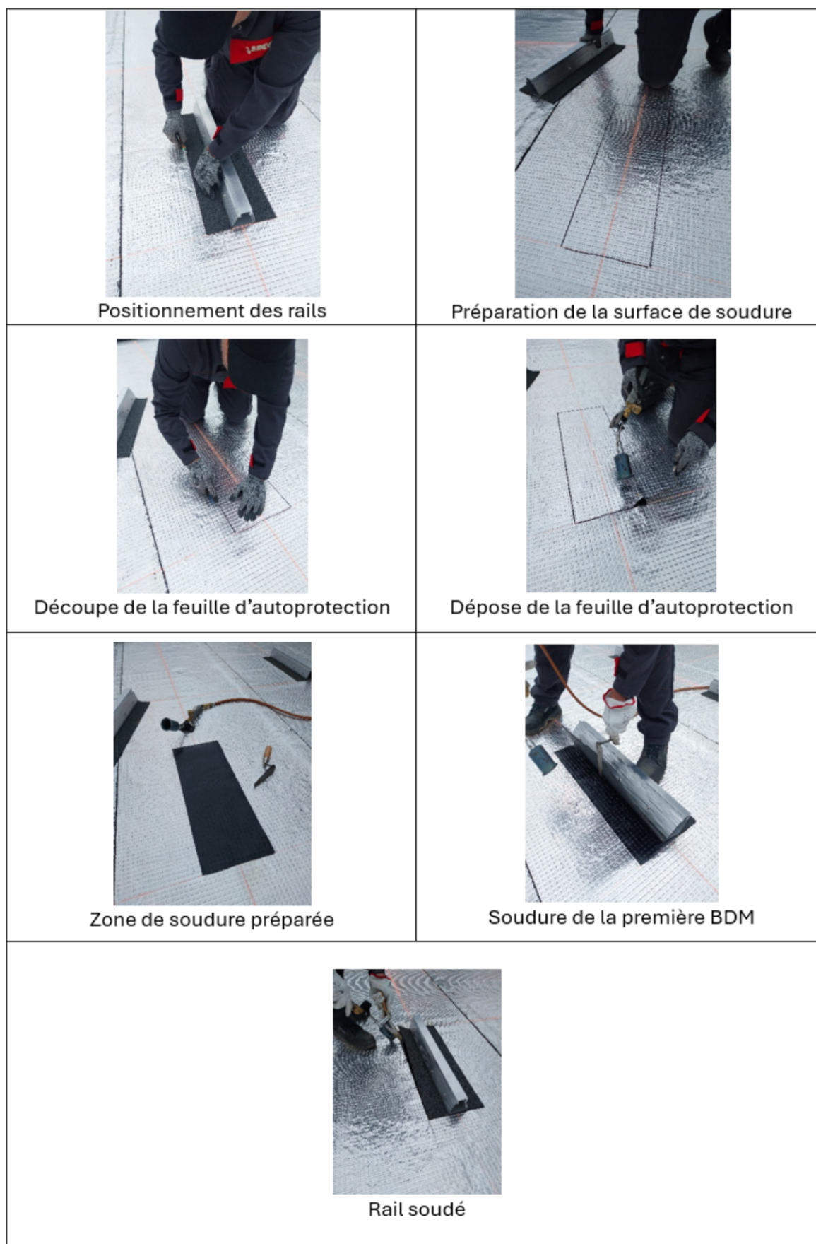
Figure 29 - Soudure d'un rail avec seconde couche aluminium
