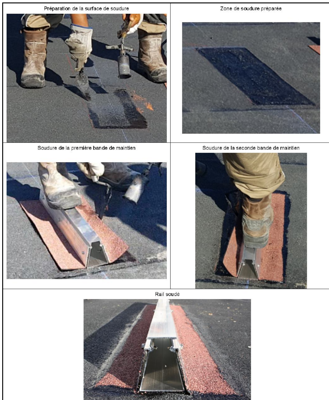
Figure 28 - Soudure d'un rail avec seconde couche ardoisée
