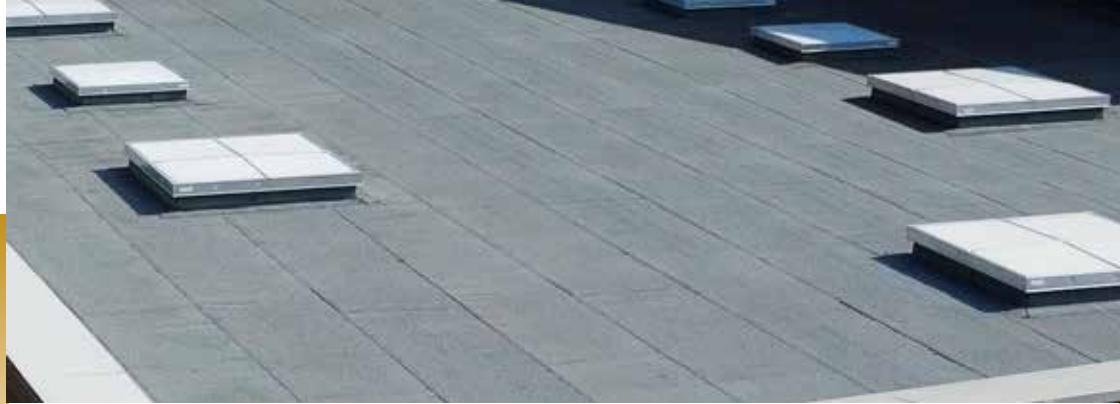
**IKO MONO ALPA AR/F** est une membrane d'étanchéité monocouche de 4 mm d'épaisseur particulièrement recommandée, en réfection, sur anciennes étanchéités ardoisées.
