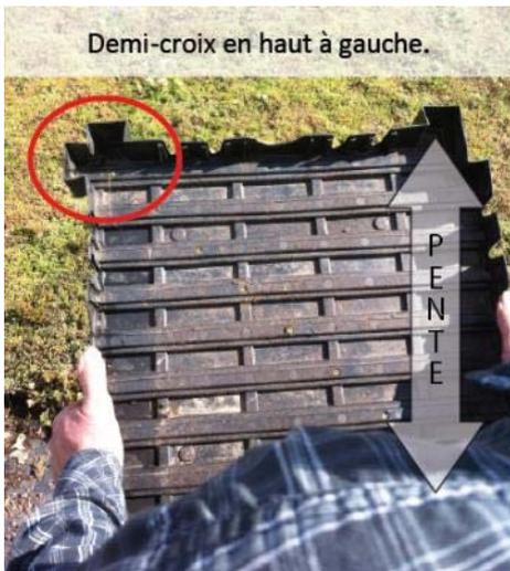
**Figure 1 – Sens de pose de la Manuplac® pour des pentes > 0 %**
