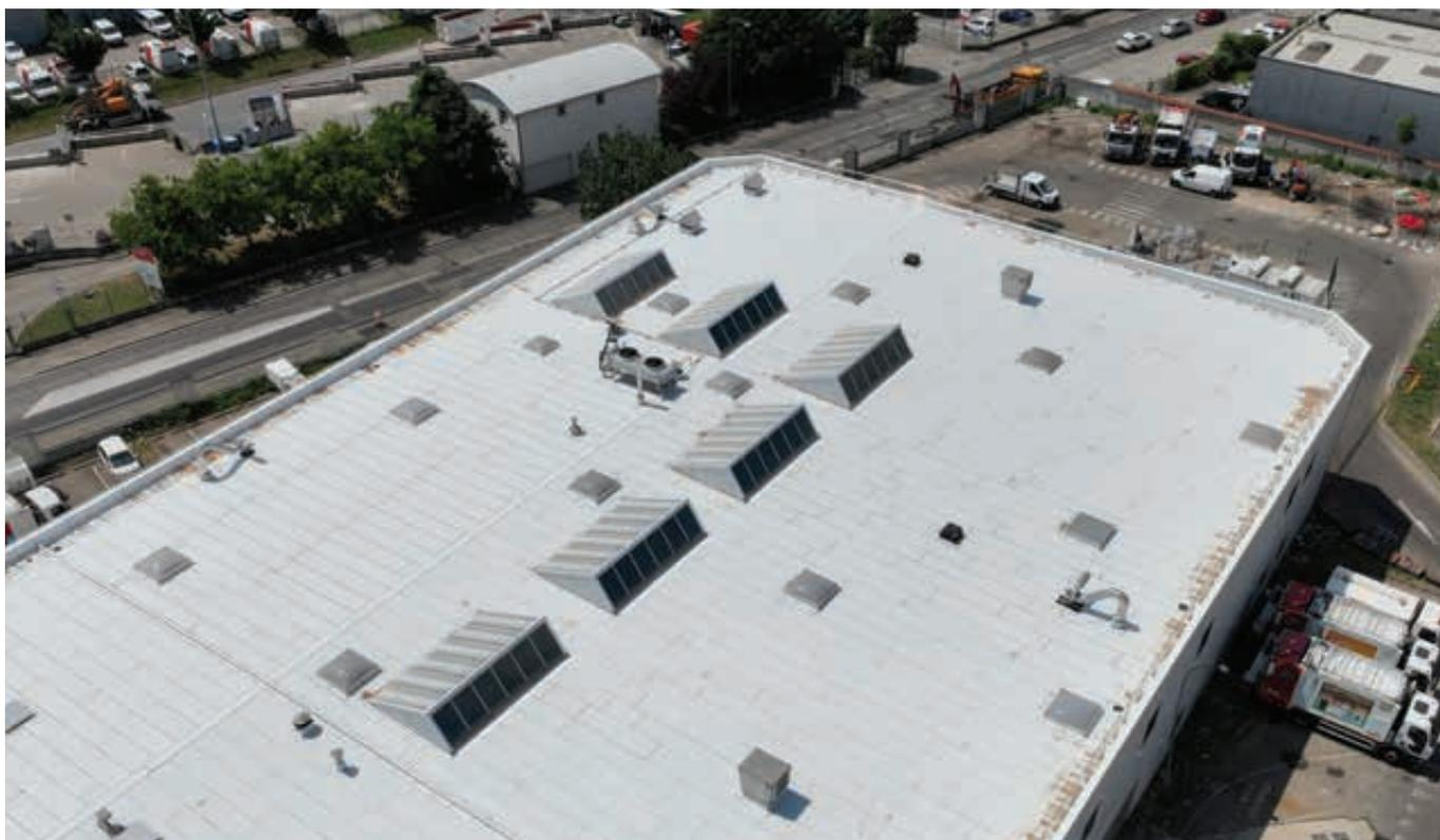
Pour **améliorer le confort thermique** des collaborateurs qui souffraient de la chaleur en été, l'entreprise SIC Étanchéité a proposé la **mise en œuvre d'une étanchéité réfléchive avec le procédé IKO DUO FUSION ALU REFLECT d'IKO**. Cette solution de cool roofing a permis de **réduire la température jusqu'à - 5°C à l'intérieur du bâtiment**.
